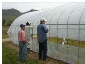
図-7 ビニール張り
